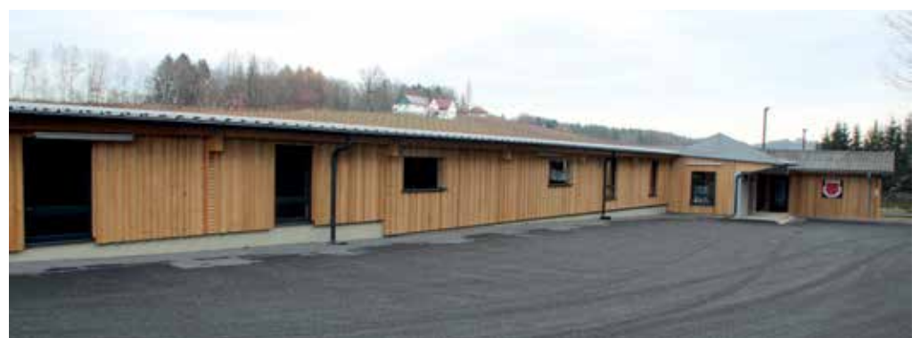
Die neue „durchaus herzeigbare“ Stocksporthalle des Eisschützenvereins Gschmaier
